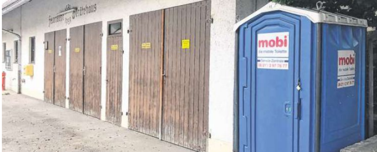
In Sulzschneid hat die Feuerwehr die einzige Freilufttoilette im Landkreis. Doch nicht nur dort hapert es mit der Nachrüstung von Sanitäranlagen. Foto: Andreas Filke
